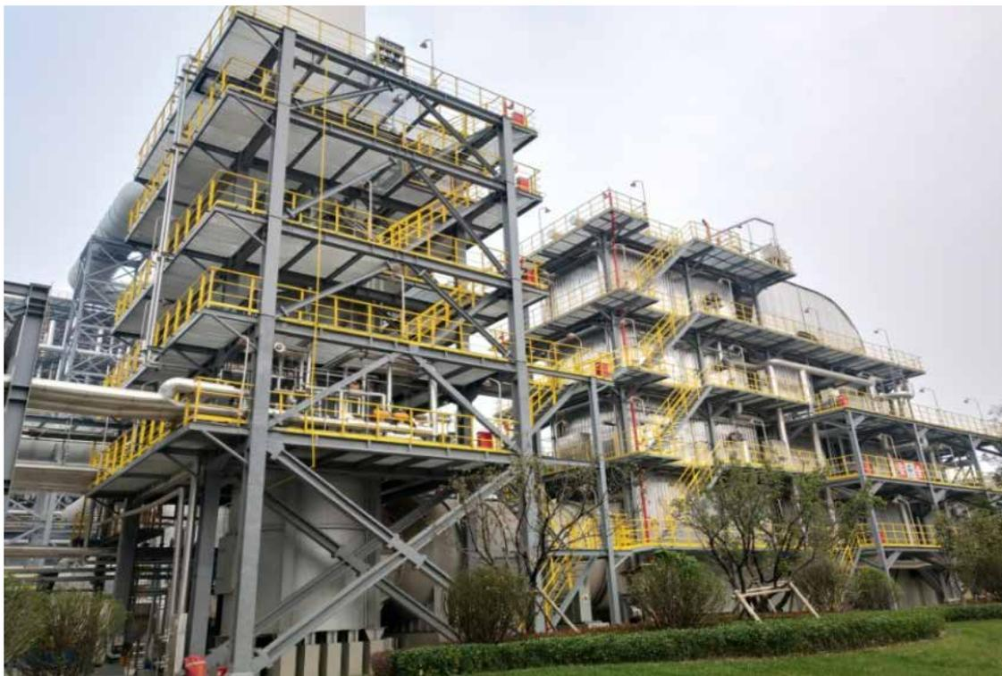
图 30 危险废物无害化——TO 焚烧装置
