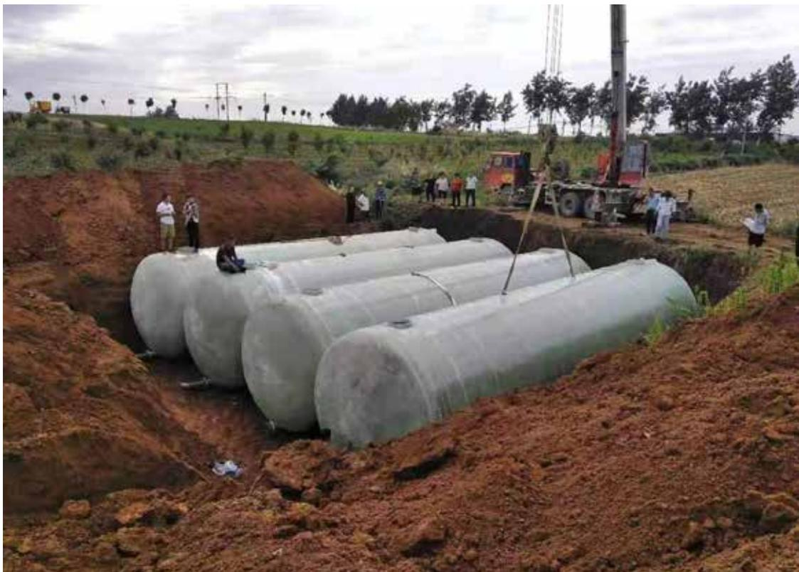
图 16 玻璃钢发酵罐深埋地下解决畜禽粪污设施建设占用耕地问题
