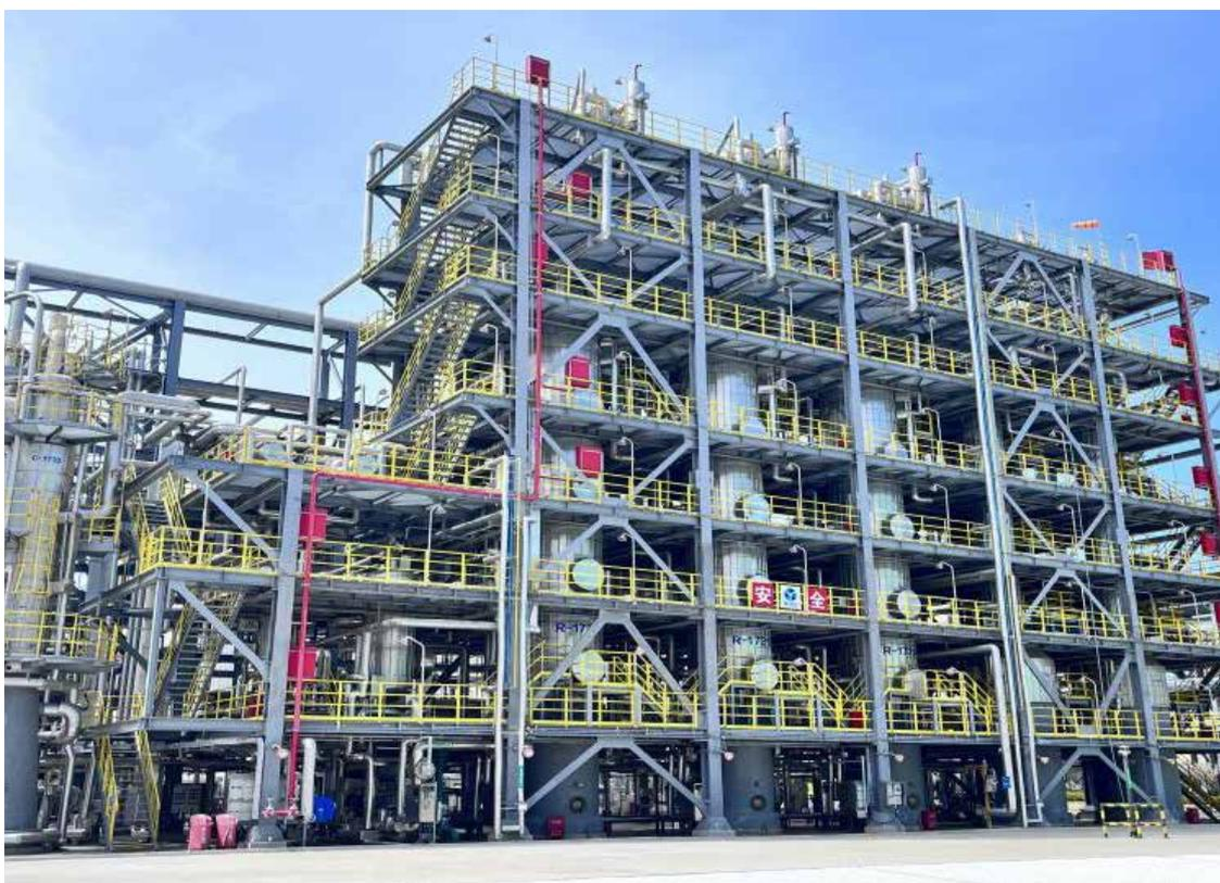
图 29 危险废物资源化——废碱液氧化装置
